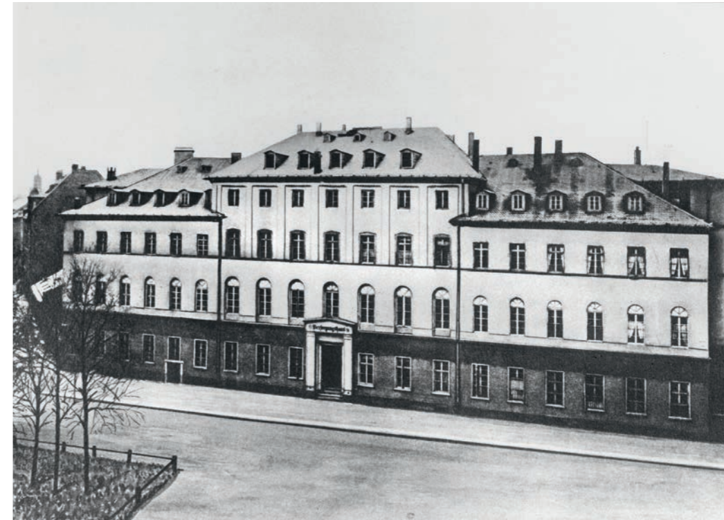
Die Schauseite des Versorgungshauses in seinen sparsamen klassizistischen Formen mit Mittelrisalit und den beiden Seitenflügeln. Im Mittelrisalit im ersten Obergeschoss befand sich die evangelische Kapelle
