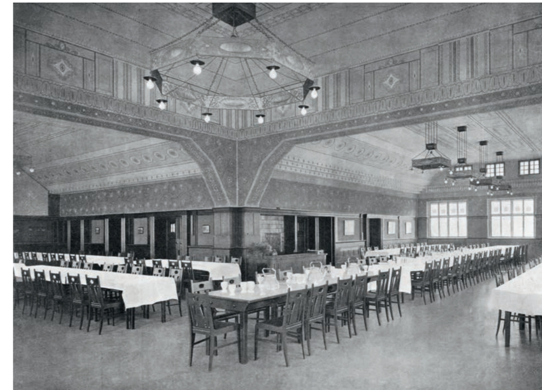
Der im Winkel aufgebaute Speisesaal des Versorgungshauses. In dem einen Flügel saßen die Damen, in dem anderen die Herren
